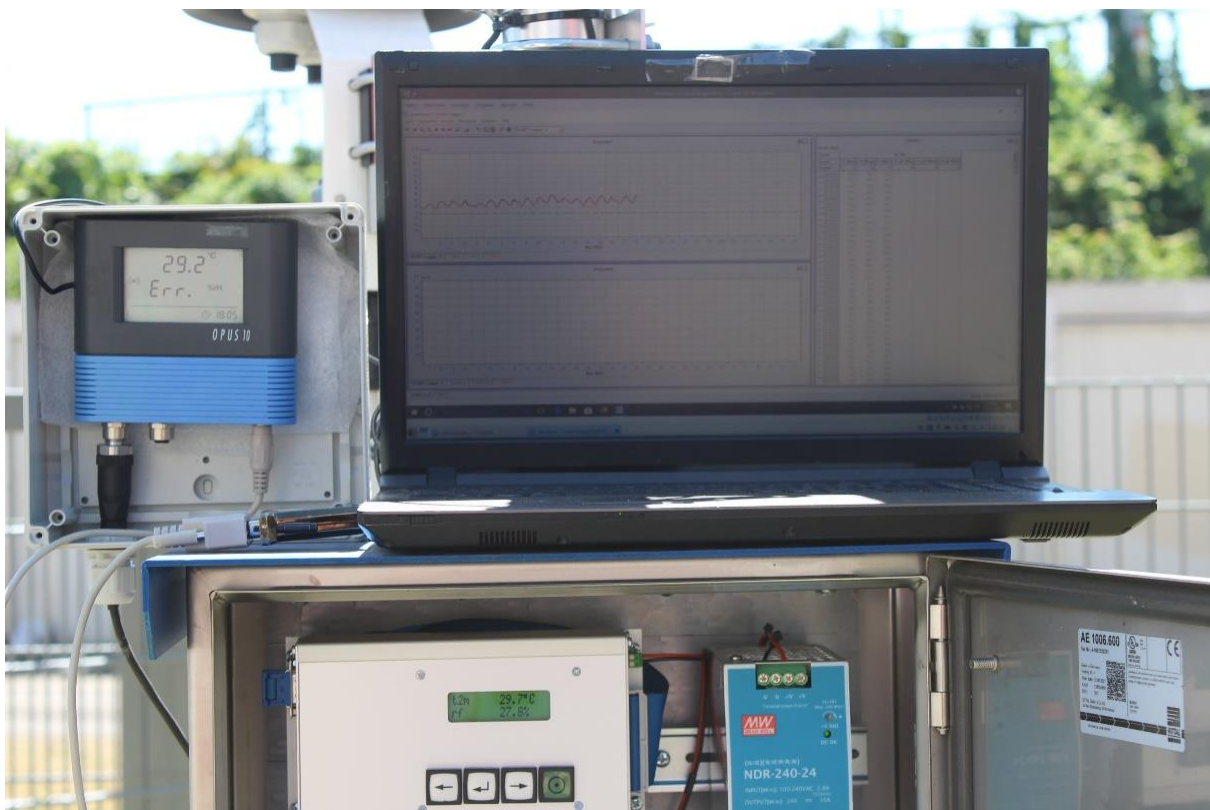
Abb. 3: Messsysteme an der Stadtklimastation „Schlossgartenstraße“ (FB 61)
